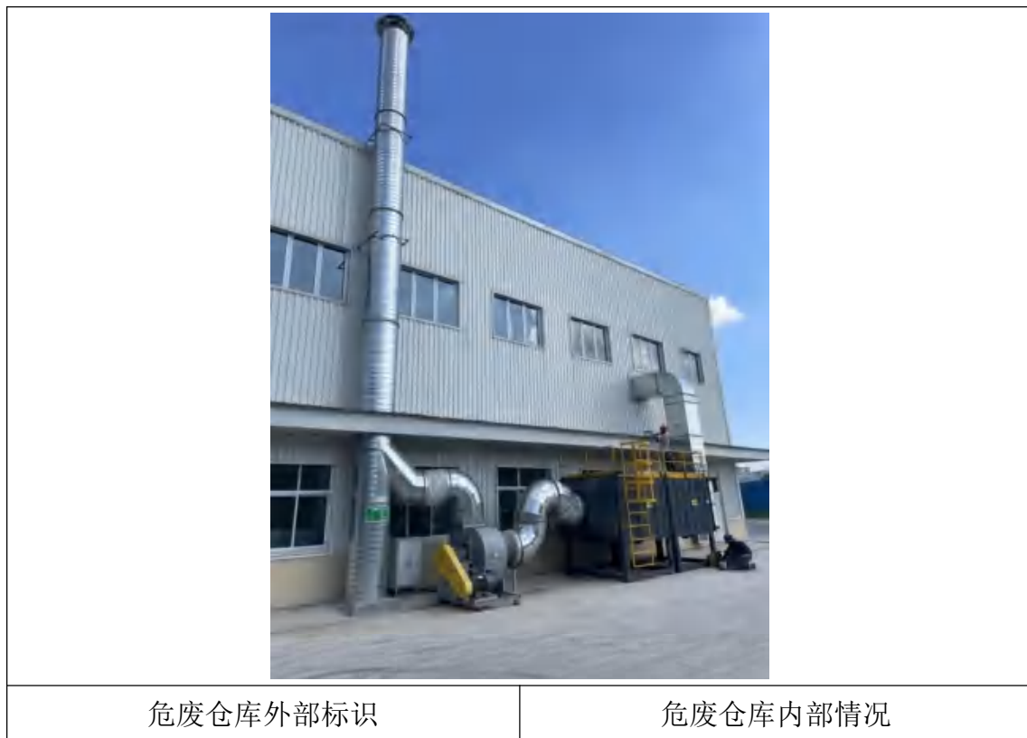
图4.1-3 泰柯棕化危废仓库现状图
